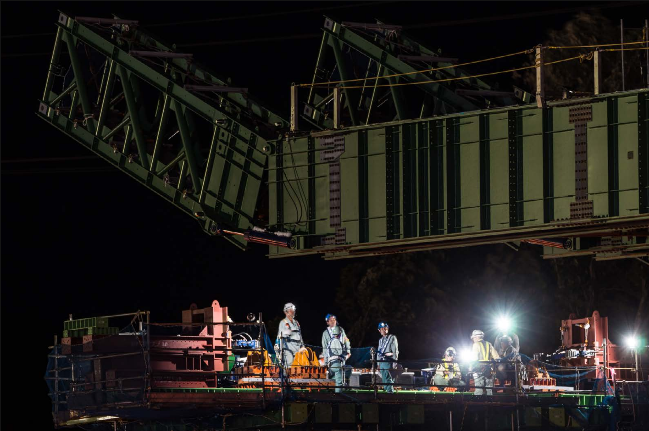
架設の成功のためには、向こう側に用意された桁の置き場所に、ズレや誤差が生じること無く、桁が届かねばなりません。真剣な眼差しが見守ります。
